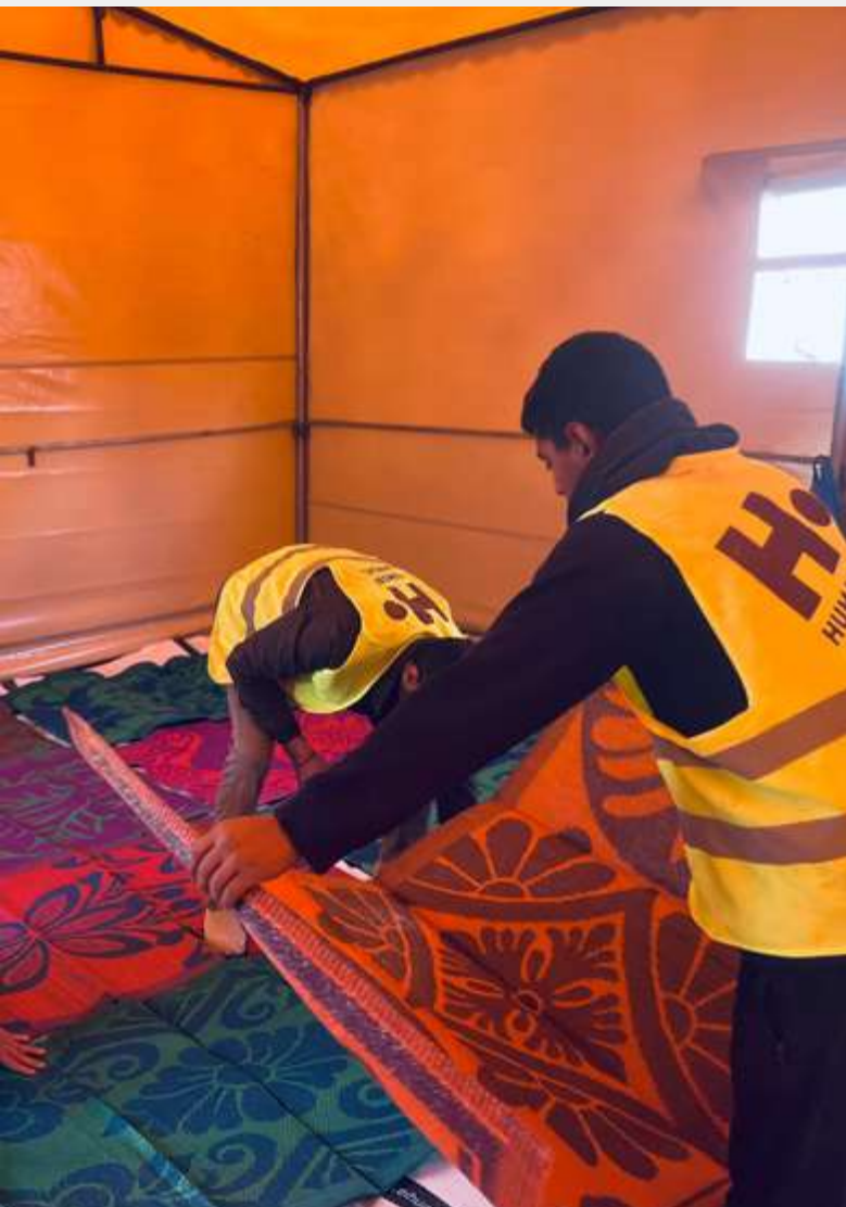
Construction de mosquées temporaires à Gaza
